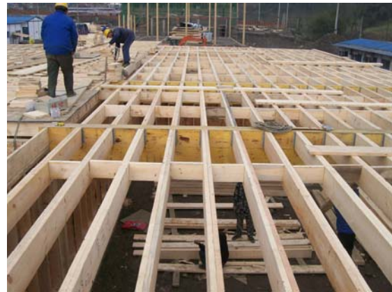
图 2 施工中的木楼盖
